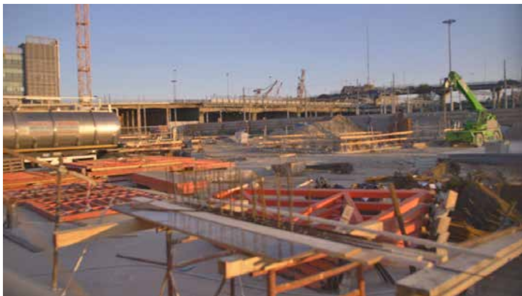
Cantiere Via Ca' Marcello
