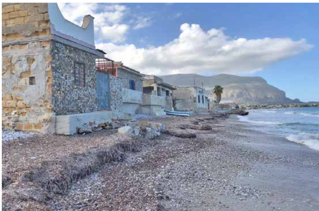
Carini - lungomare - edifici abbandonati
