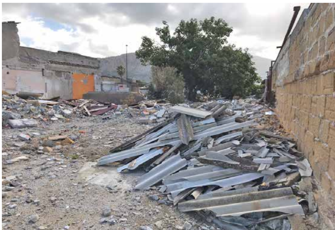
Carini - lungomare - demolizione immobili abusivi - rifiuti pericolosi
