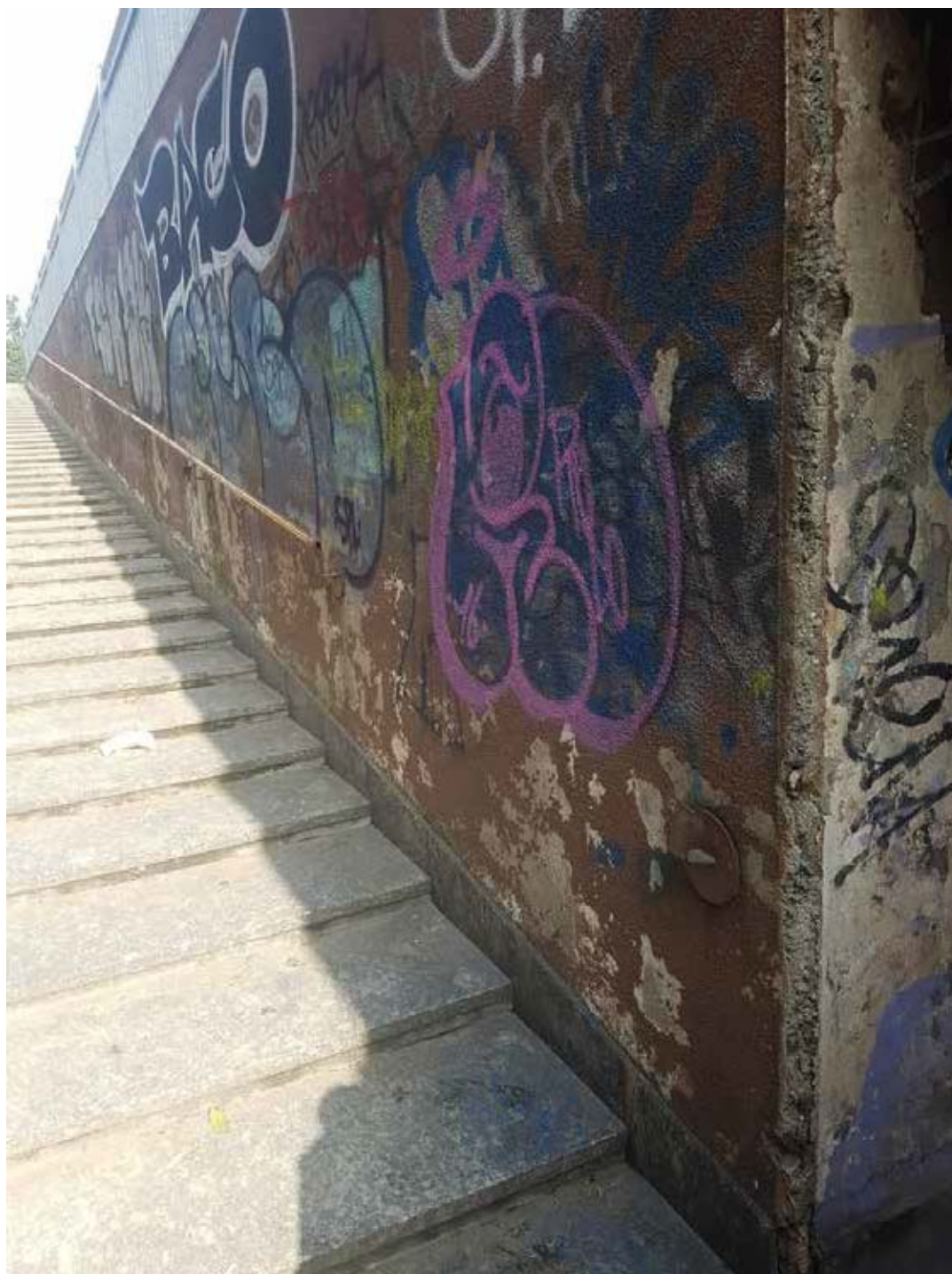
Sottopasso di Crescenzano prima dell'intervento di riqualifica
